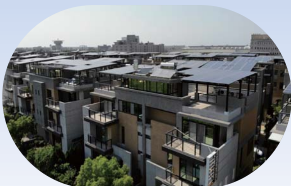
社區民宅屋頂設置情形
